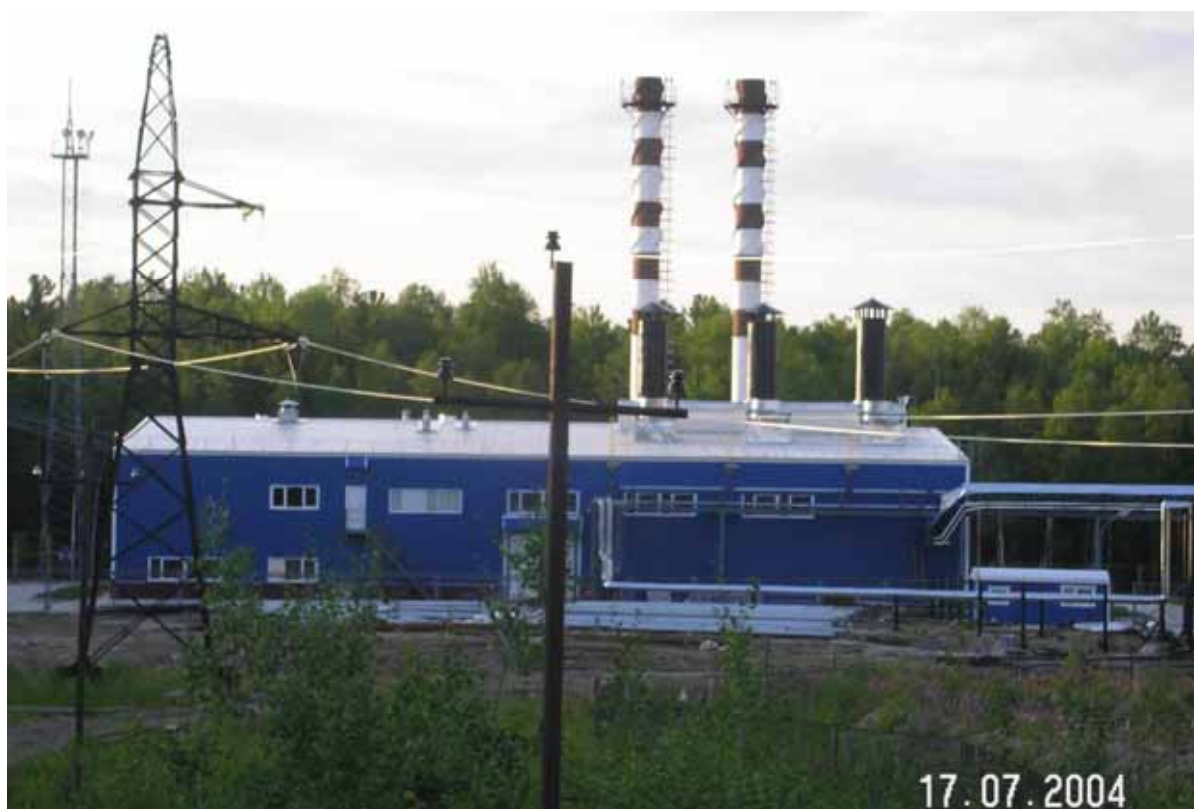
Фото 3. Главный корпус «ГТЭС-7,5 МВт»
