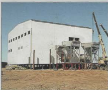
Монтаж оборудования многоагрегатной электростанции месторождения «Хасырейское»
