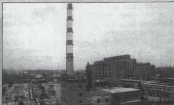
Елецкая ТЭЦ перед модернизацией. Переход в парогазовый цикл позволит увеличить \eta_{нд} энергоблока до 52%
