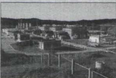
КС «Игринская» – опытная площадка для натурных испытаний лидерной установки ГТУ-25П
